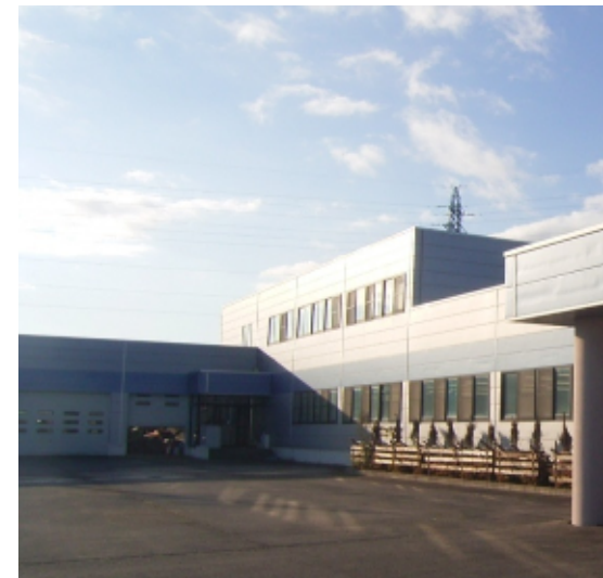
青森支社（敷地面積：1,750坪）
