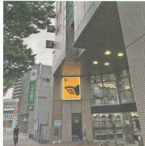
前橋の中心部にある1993年建設の本店
